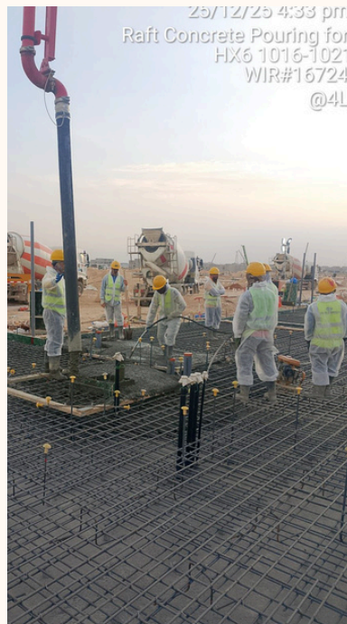
Raft Concrete Pouring for DR C20-1635 WIR#16772 4E
