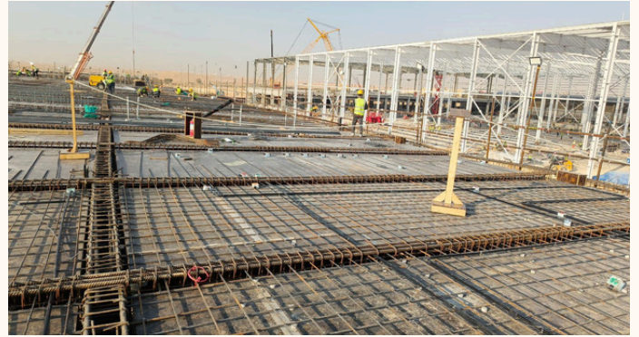
25/12/25 4:33 pm Raft Concrete Pouring for HX6 1016-1021 WIR#16724 @4L
